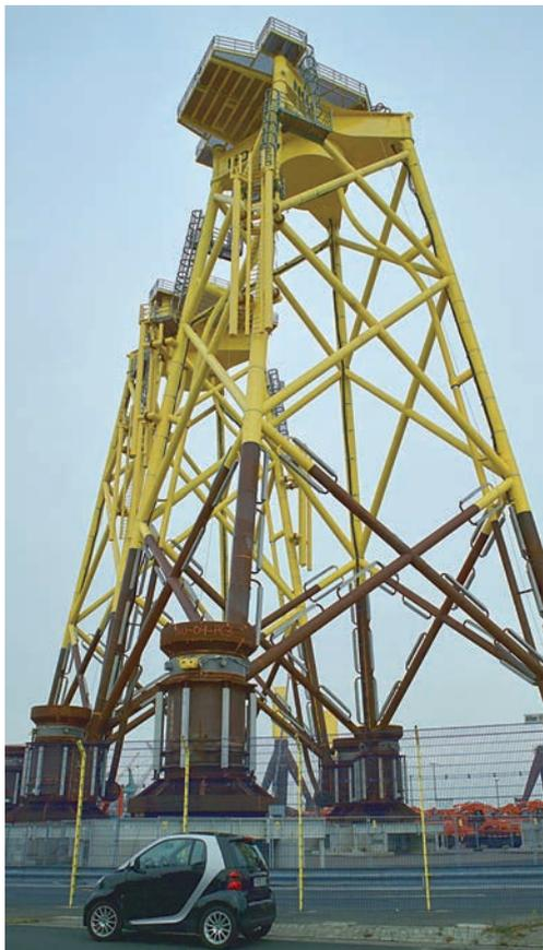
**Bild 1** Jacket-Tragstruktur mit Stahlhülsen für die Grouted Joints
